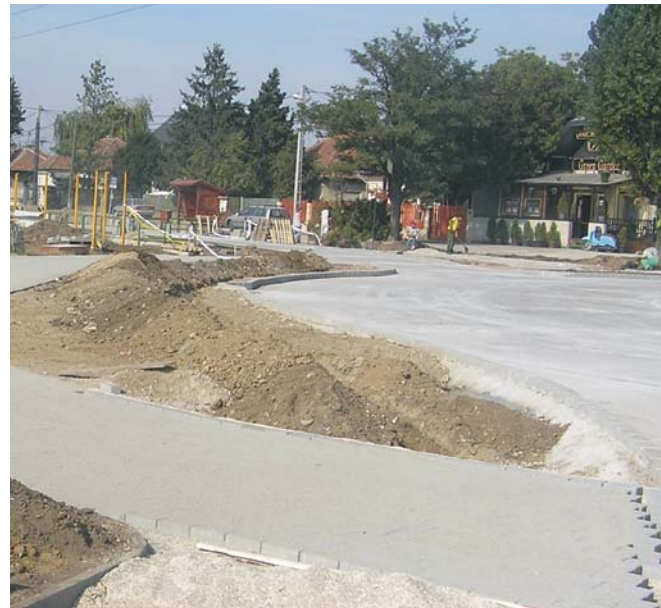
A betonburkolat forgalomtechnikai előnye is jelentős, hiszen a világos felület éjszaka és esőben egyaránt jó látási viszonyokat teremt.
